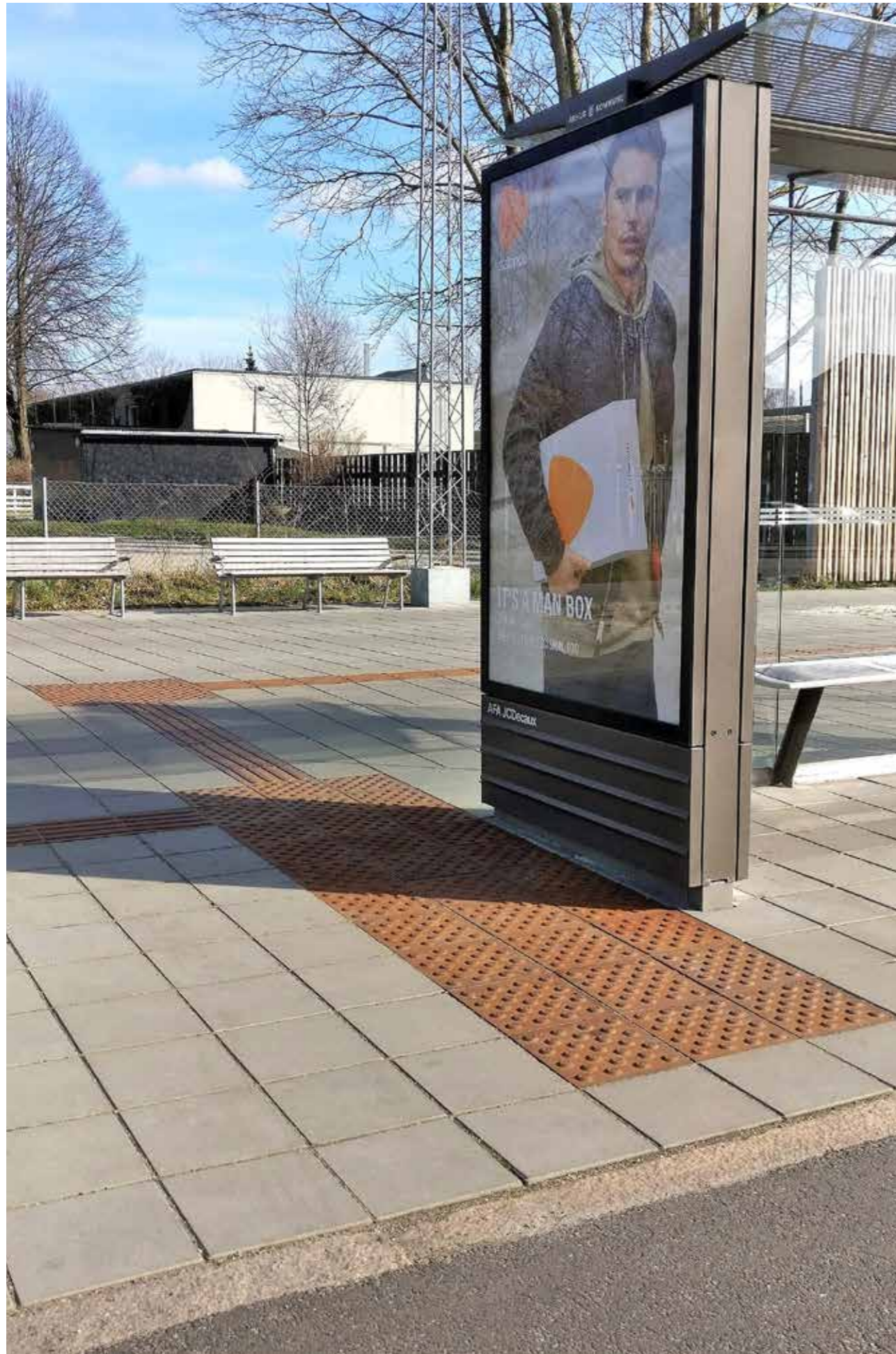
Der placeres et kvadratisk eller rundt opmærksomhedsfelt, hvor ledelinjer mødes, vinkelret på opmærksomhedsfeltet. Pictoform® Støbejernsflise m. Ø36 mm knopmarkering samt Pictoform® 36 Flise m. 4 ledelinjer / Århus Bymidte.
